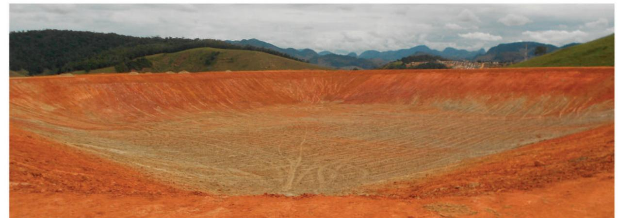
Construção das lagoas que, após impermeabilização, receberão cerca de 50 milhões de litros de água para fertirrigação.
